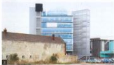
1 - Le Dôme offre trois plateaux libres de 500 m 2 en double hauteur. 2 - Les façades latérales sont surmontées d'un toit terrassé.
