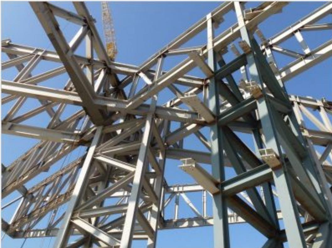
C'est sur ce noyau central que reposent les poutres principales qui forment la structure du bâtiment.
