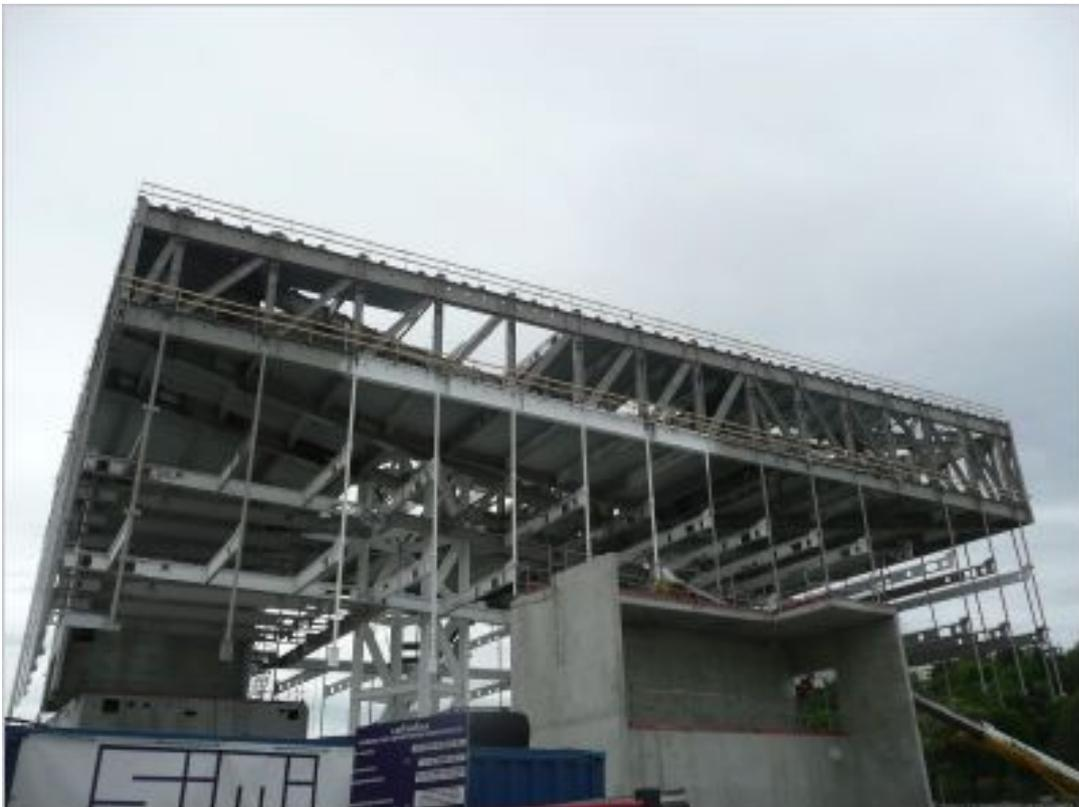
Une seule pile béton réunit les équipements sanitaires et tout le système technique.
