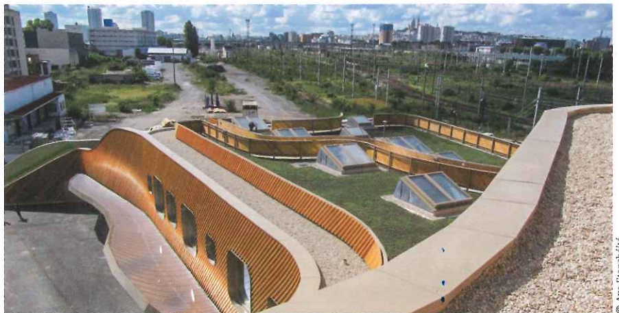
La forme de la toiture ne compte aucun angle.
