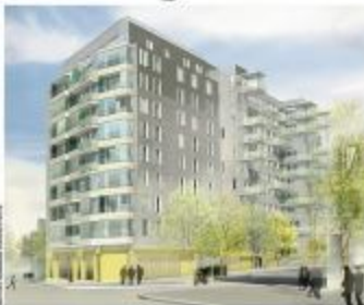
La façade est et ouest de la barre, des extensions adossées permettent d'être des balcons et d'agrandir les cuisines.
