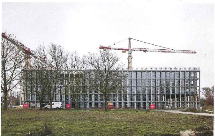
La structure métallique se déploie sur les quatre côtés du bâtiment.
