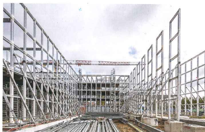
Éléments modulaires de structure (avec bracons provisoires).
