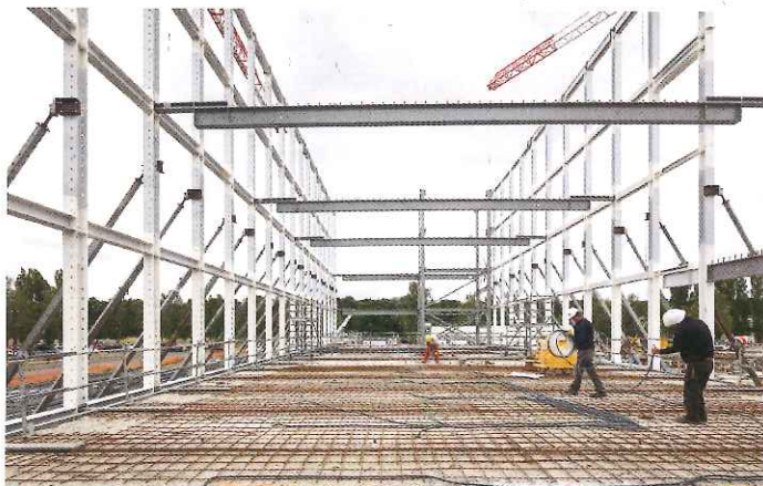
À sa jonction aux poteaux, la poutre passe de 40 à 15 cm d'épaisseur.
