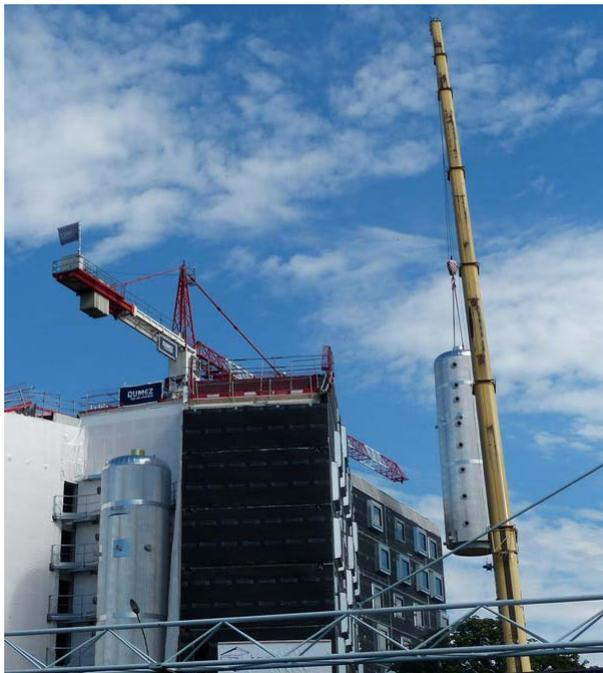
Les deux cuves se chargeront en chaleur grâce à un voile de 300 m<sup>2</sup> de panneaux solaires thermiques à tubes sous vide qui viendra recouvrir toute la face sud du bâtiment.
