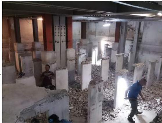
Démolition d'un niveau de plancher et des ailettes porteuses après le passage de la nouvelle structure porteuse et le coulage du radier
