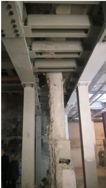
Mise en charge de la nouvelle structure porteuse
