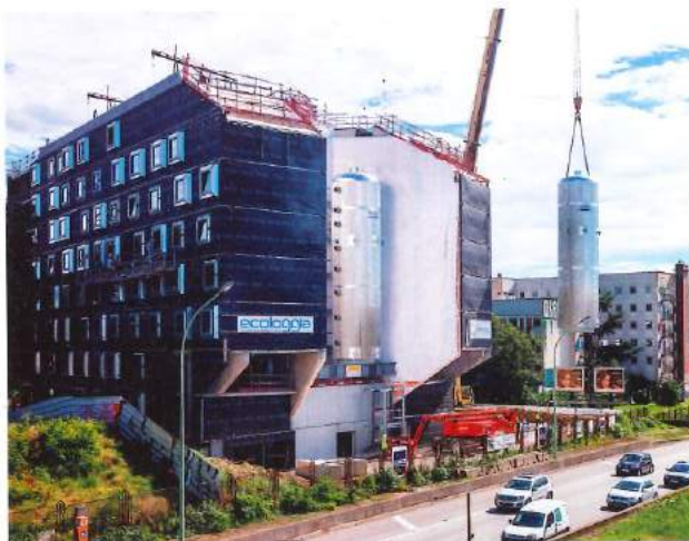
Mise en place des cuves, d'une capacité de 78 m 3 chacune.
