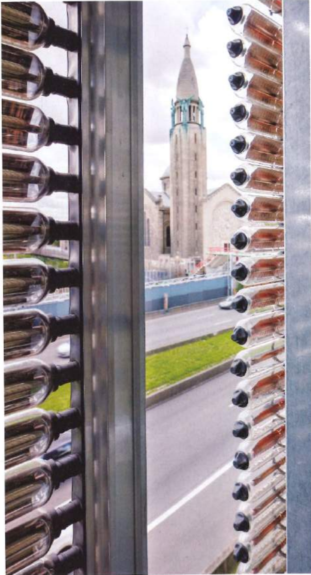
En façade, les tubes solaires thermiques sous vide chauffent l'eau stockée dans les réservoirs géants.
