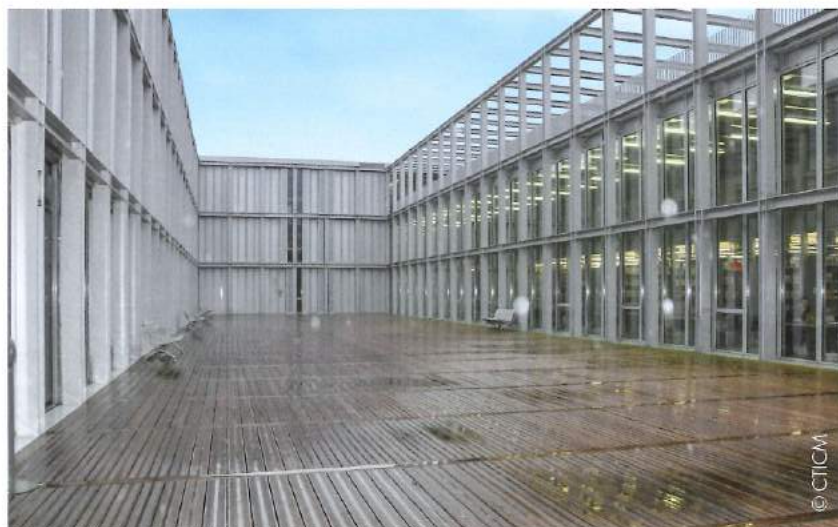
Le patio minéral au 2 e étage
