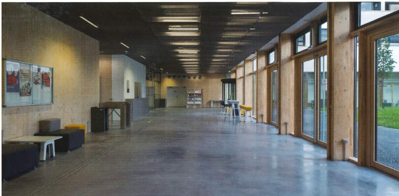
▲ Dans un souci de cohérence, l'architecte a laissé apparents les bois de structure. Les faux plafonds des circulations et du hall d'entrée sont traités avec du métal déployé qui laisse deviner les réseaux techniques.
