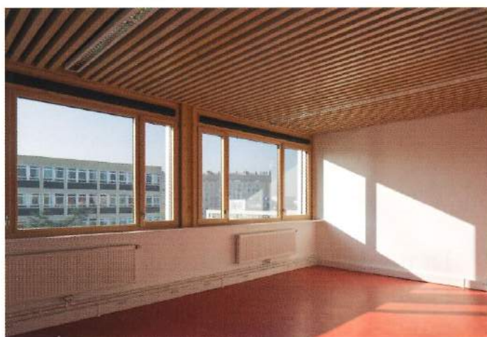
▲ Les fenêtres des bureaux sont équipées de stores extérieurs et de prises d'air en imposte. Les réseaux de chauffage et d'électricité sont majoritairement disposés le long des murs de façade pour préserver la flexibilité du plan.
