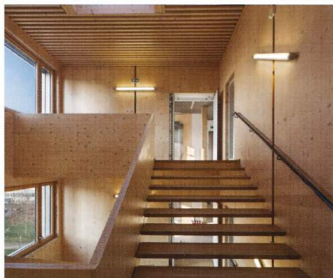
▲ L'escalier principal, entièrement en bois de structure d'épicéa, est pensé comme un lieu de rencontres et d'échanges, portes coupe-feu ouvertes sur les étages de bureaux.
