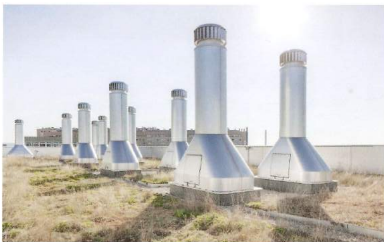
▲ Huit gaines de ventilation (deux par étage) sont regroupées dans chacune des 25 tourelles fabriquées sur-mesure d'après les dessins de Pascal Gontier.
