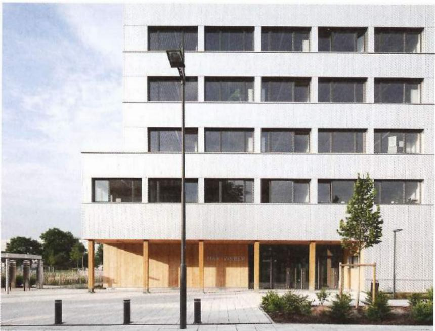
Page de gauche, en bas, logements sociaux pour Aquitanis dans la métropole bordelaise. Ses principales caractéristiques : une structure 100 % bois (sans noyau béton), une isolation en paille et une ventilation
