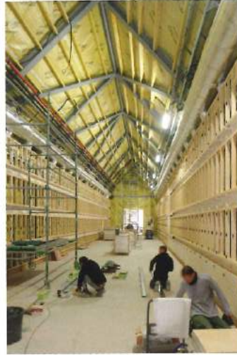
▲ Vue de l'ossature avant le montage des panneaux de bois.
