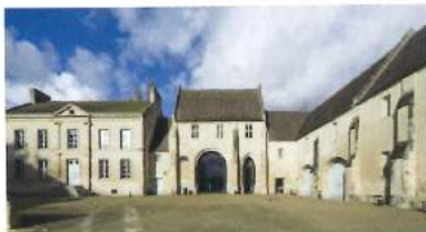
▲ Vue depuis l'entrée de l'ancienne cour de ferme après travaux d'aménagement.
