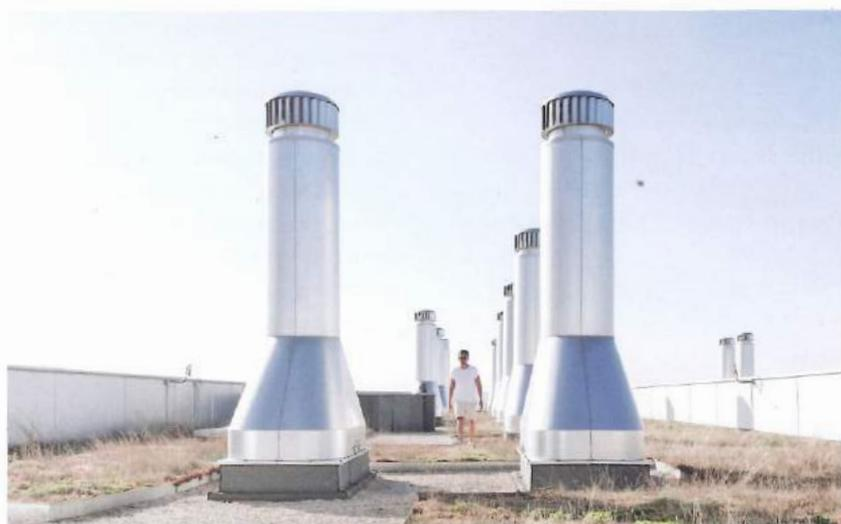
*Bâtiment Max Weber pour l'université Paris Nanterre (2012-2016), par l'Atelier Pascal Gontier. Si le bâtiment possède une enveloppe de type passive, il comporte un dispositif de ventilation naturelle assistée et contrôlée qui permet d'éviter les consommations de ventilation mécanique double flux que l'on retrouve habituellement dans ce type de construction. Des réseaux verticaux largement dimensionnés et 25 cheminées de ventilation permettent de répondre à cet objectif.*
