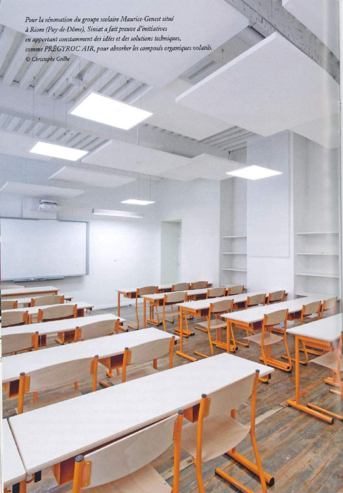
Au moment de la construction, il existe des solutions qui permettent de traiter la pollution de l'air intérieur. La ventilation est évidemment importante et doit être parfaitement maîtrisée. Mais il est judicieux de la coupler avec des matériaux dits « actifs », comme nos plaques de plâtre de la gamme CAPT'AIR chez Siniat, qui sont capables de réduire les taux de formaldéhyde sur le long terme.
