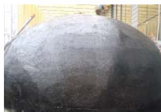
Etanchéité sur Foamglass
