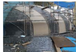
Béton projeté de la couche de finition réalisé par passes alternées et ouvrage finalisé
