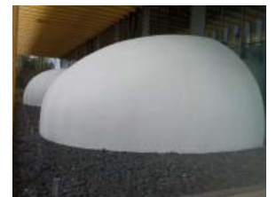
Béton projeté de la couche de finition réalisé par passes alternées et ouvrage finalisé
