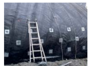
Etanchéité complémentaire sur platine d'accroche
