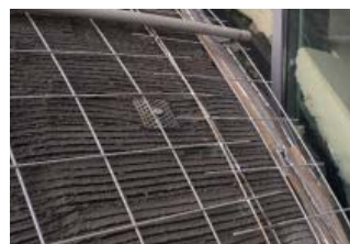
Treillis soudés sur scratch pointé sur platine d'accroche formant ferrailage de la couche de finition
