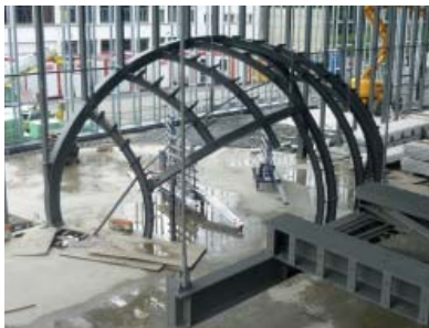
Ossature primaire métallique
