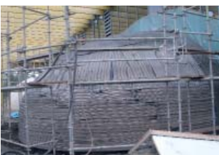
Nergalto pour accroche du scratch en béton projeté
