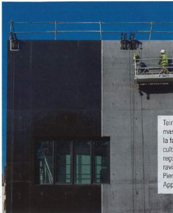
Teinté noir dans la masse, le béton de la façade de l'Espace culturel de Chaville (92) reçoit la protection ravivante effet mouillé Pieri Protec PU 50 de GCP Applied Technologies.
