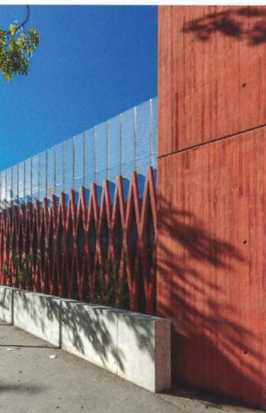
Mariage réussi entre la préfabrication et le coulé en place. Stade de tennis de la porte des Lilas, à Paris. Architecte : Bruno Mader.
