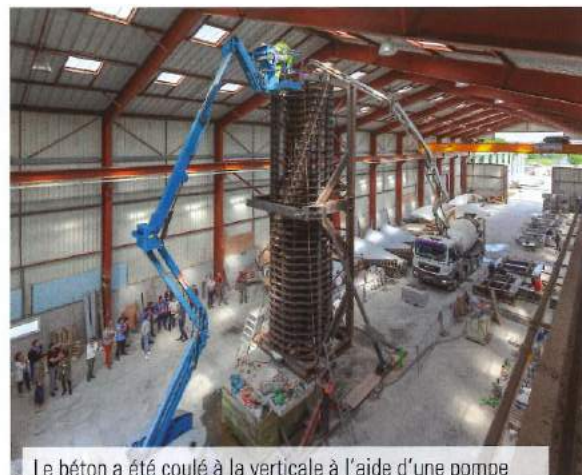
Le béton a été coulé à la verticale à l'aide d'une pompe dotée d'un bras télescopique perché à 12 m de haut.
