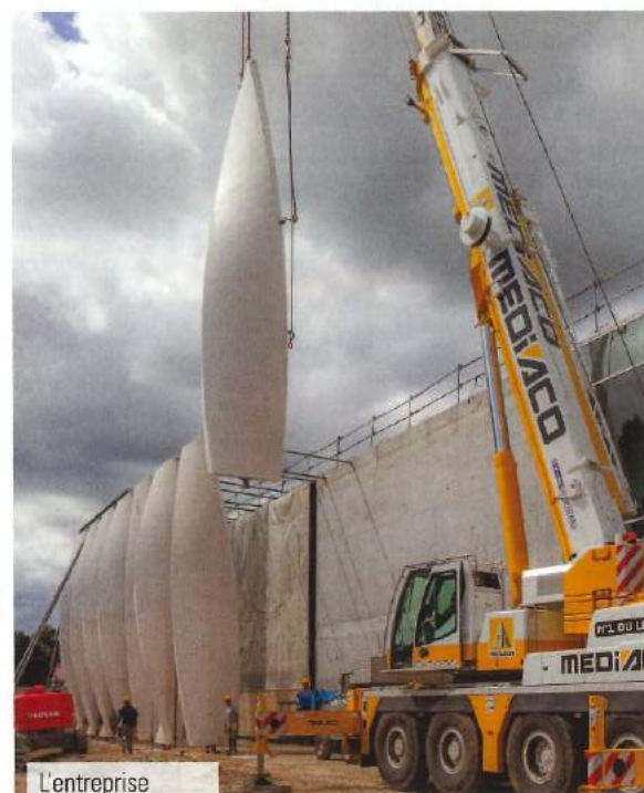
Le béton a été coulé à la verticale à l'aide d'une pompe dotée d'un bras télescopique perché à 12 m de haut.
