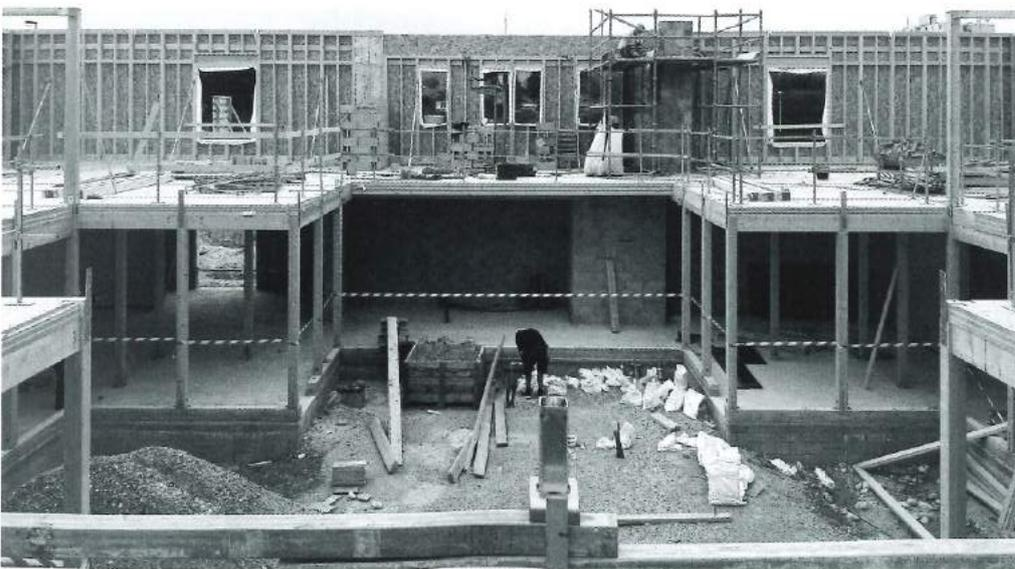
Sur le chantier, le plancher de l'étage en panneaux bois lamellé-croisé, associé à des murs à ossature bois.
